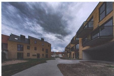
Er is een doorgang voor fietsers en voetgangers naar een pad dat doorheen de gemeenschappelijke tuin loopt.
