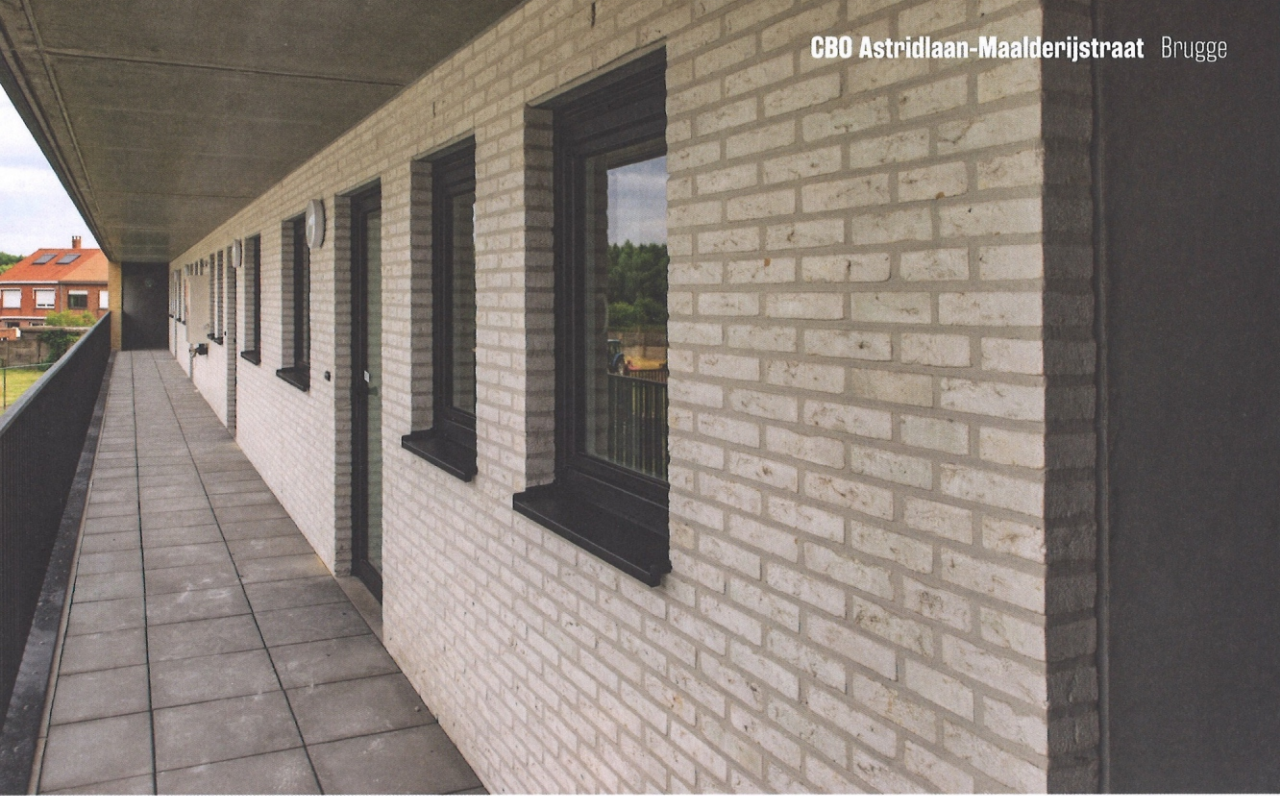
Alle balustrades voor de lange gaanderijen werden in frontmontage geïnstalleerd.
